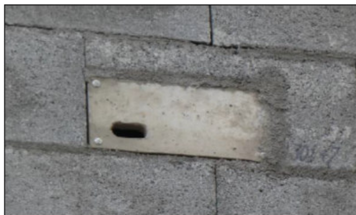
Figure 22 : Exemple de nichoir à martinets encastré
